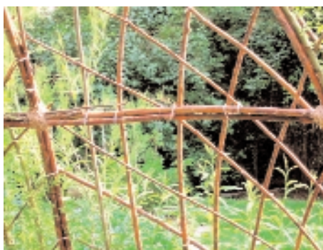
Die Weidenruten sind mit Kabel- bindern temporär miteinander verknüpft
